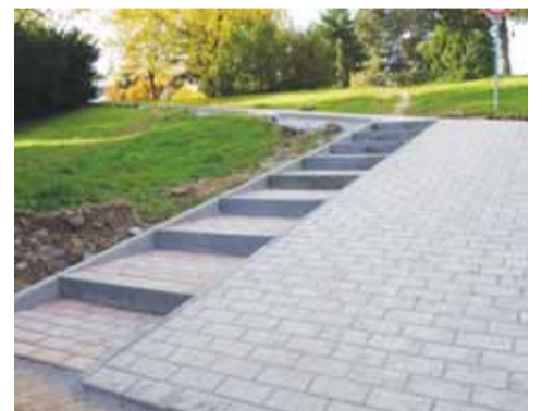
Chodník a schody na Ul. M. Belu
