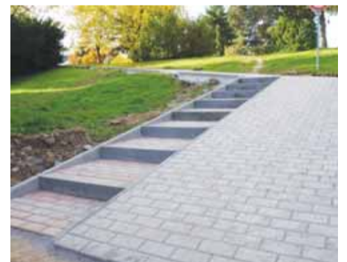
Chodník a schody na Ul. M. Belu
